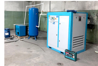
Пусконаладка в ООО "Мешкоград"
